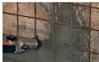
L'intervento di ristrutturazione si completa con un ciclo di intonacatura e finitura o, in alternativa, con la rasatura fibrorinforzata GEOACTIVE FINE B 543; per limitare il potenziale evidenziarsi di microcavillature si consiglia di inserire una rete in fibra di vetro all'interno della finitura o della rasatura.
