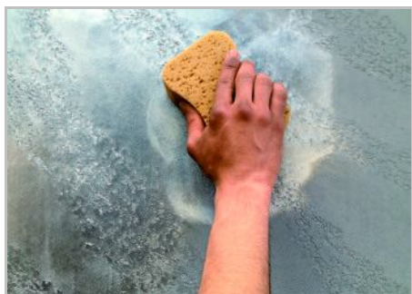
Fase 6 - Realizzare la finitura desiderata con Gioia, Oro, White Paint o Cera del Vecchio. Se lo si desidera, dare una protezione con Vetro-Frammenti.
