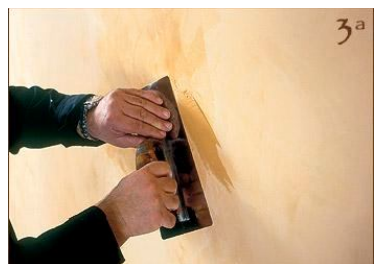
Fase 7 – A questo punto il prodotto penetrará in ogni piccola fessura e con una leggera pressione la superficie sará perfettamente liscia. Appliciamo e togliamo Spatula e togliamo Spatula Stuhhi per circa 1 mq e ...
