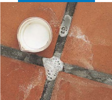
Pulizia di efflorescenza
