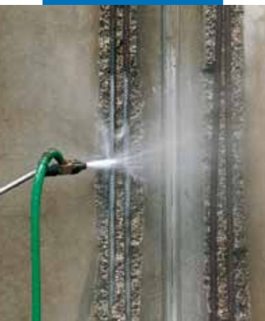
Pulizia dei ferri con idrosabbatura
