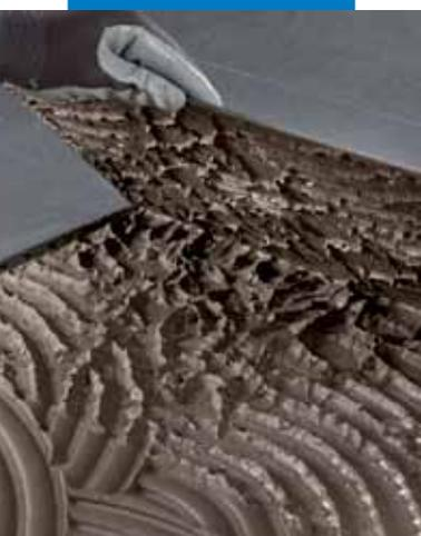
Verifica della completa bagnatura del retro delle piastrelle di grès porcellanato di spessore sottile
