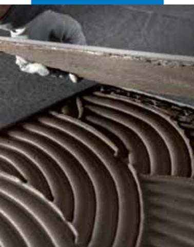
Posa a pavimento di lastre di grès porcellanato a spessore sottile
